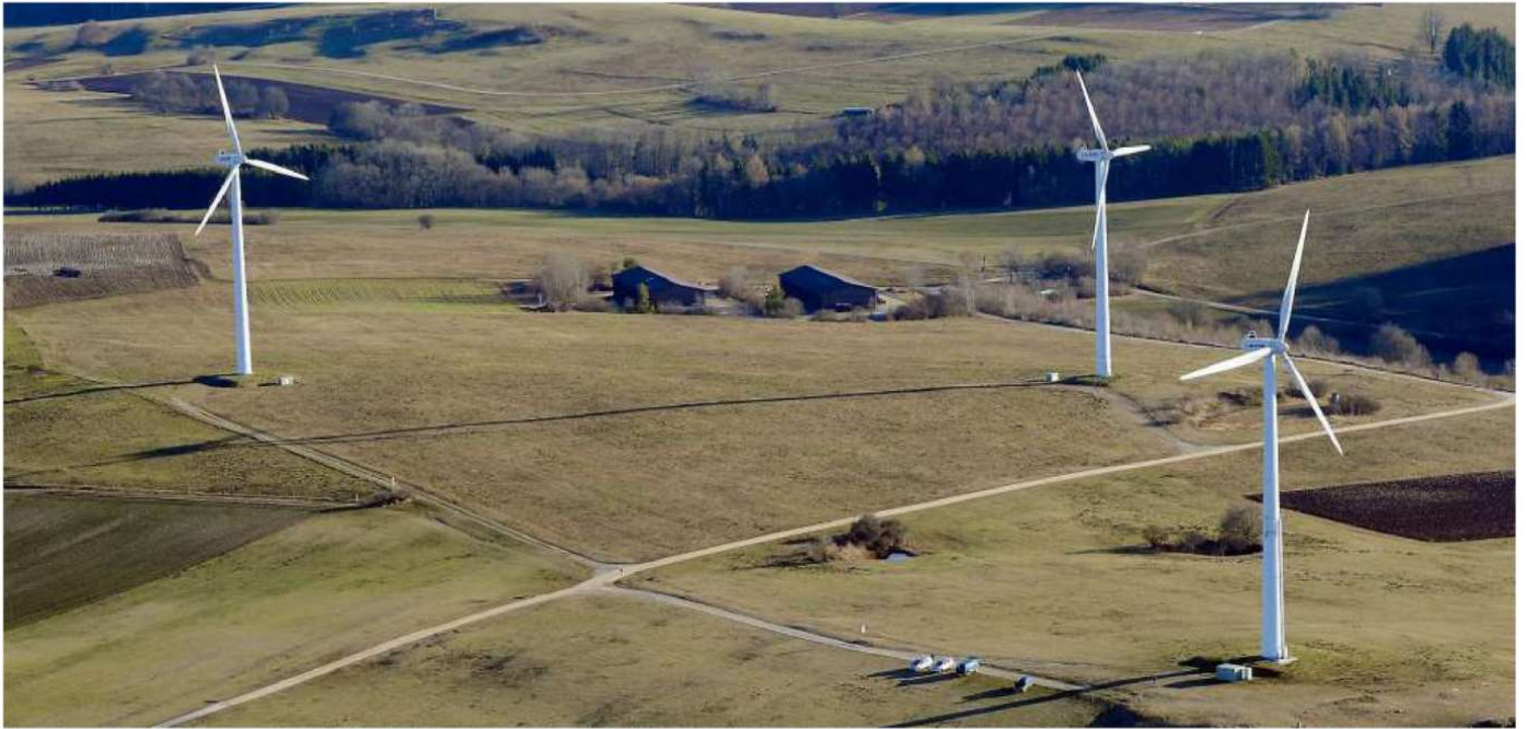
Größer als diese Windkraftanlagen auf dem Himmelberg bei Melchingen wären die Windräder, die künftig vielleicht im Norden Rottenburgs gebaut werden. Archivbild: Klaus Franke
