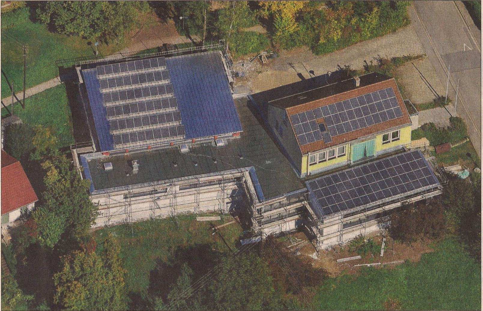
Eine der jüngsten beiden Fotovoltaik-Anlagen, die die erneuerbare Energien Rottenburg (eER) installieren ließ, ist auf dem noch im Bau befindlichen Bürgerhaus in Weiler (unter dem großen Dach und dem Flachdachtrakt) sowie auf dem ehemaligen Rathaus (Ziegeldach) und dem neuen Anbau für die Ortsverwaltung unter dem Pultdach am bisherigen Rathaus. Das alte Rathaus steht künftig allein der Feuerwehr zur Verfügung.
