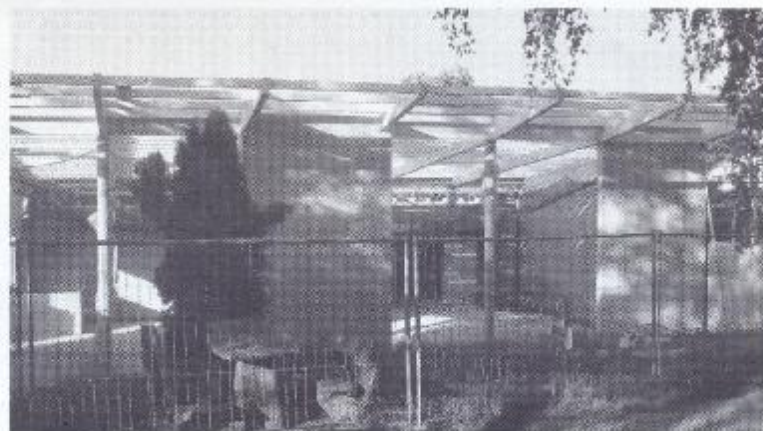
Zum ersten Mal konnten die Bürger von Weiler das Bürgerzentrum besichtigen. Und es kamen so viele, dass der 160 qm große Raum fast nicht ausreichte, um sie alle aufzunehmen. Nun ist zu hoffen, dass die Arbeiten am Bau weiterhin so gut voranschreiten, damit im nächsten Winter die Weilermer ihr Bürgerzentrum einweihen können
